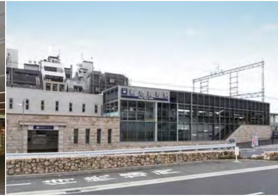
● 阪急御影駅 バリアフリー化工事
