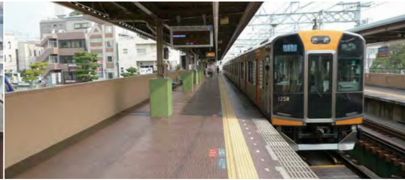
○ 阪神芦屋駅 ホーム拡幅工事
