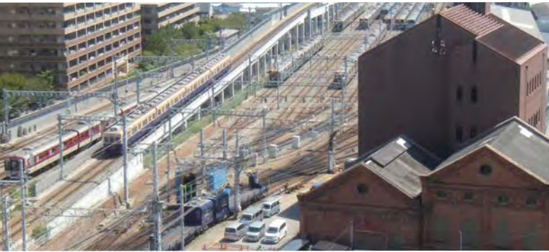
○ 阪神尼崎駅 改良工事
