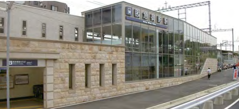
○ 阪急御影駅 整備工事
