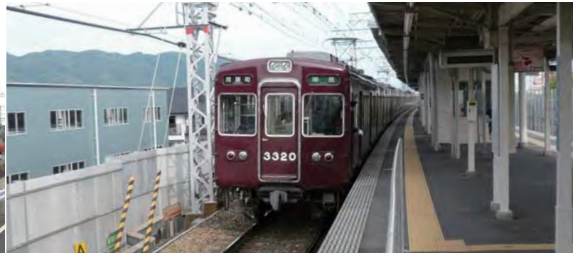
○ 阪急上牧駅 防音壁設置工事
