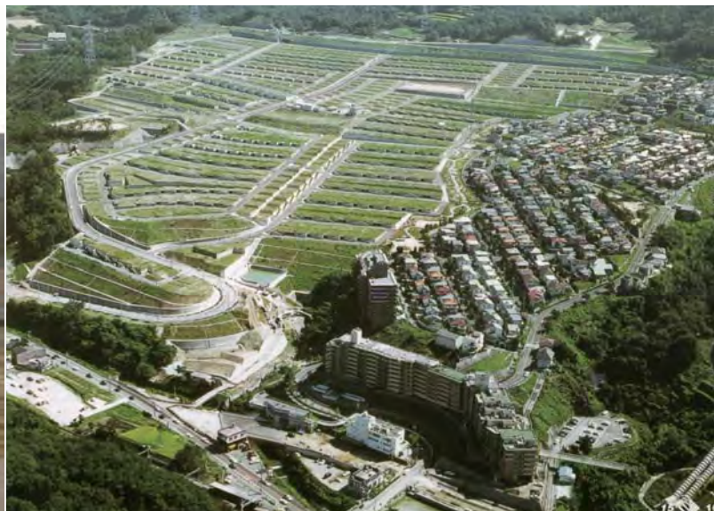
○ 神戸花山手団地 造成工事
