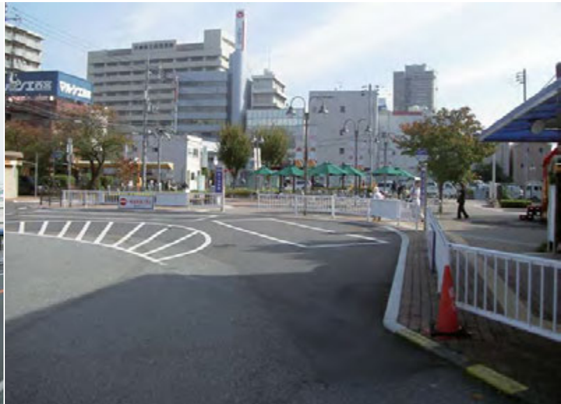
○ 阪神西宮駅 バスターミナル改築工事
