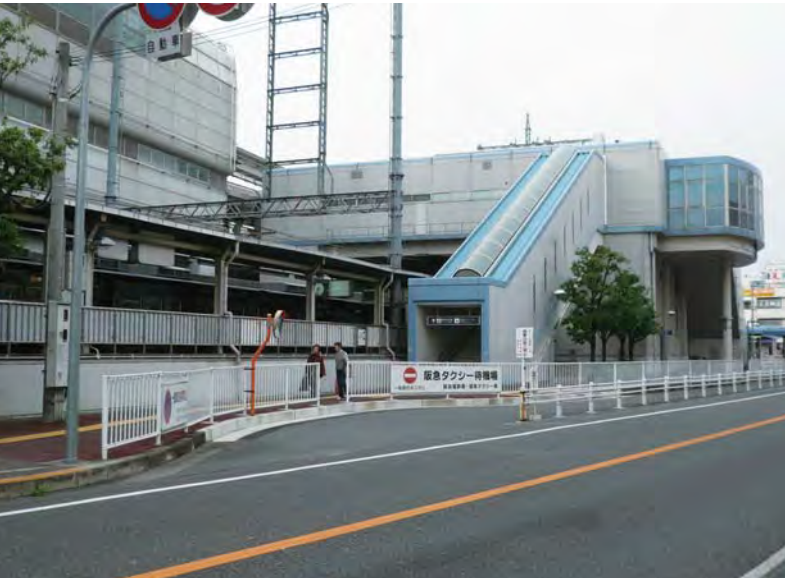
○ 阪急蛸池駅 構外歩道拡幅工事
