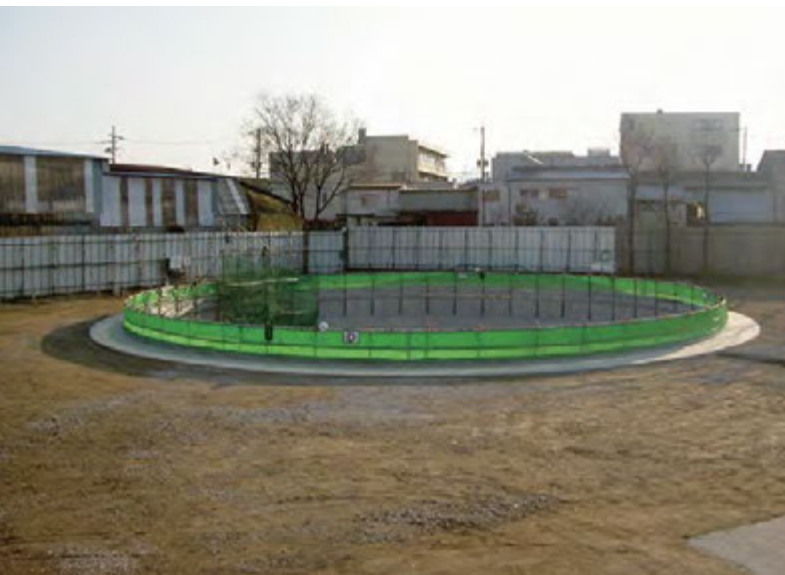
○ 大東門真増補幹線 下水管渠築造工事
