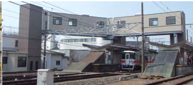
○ 山陽高砂駅 改造工事
