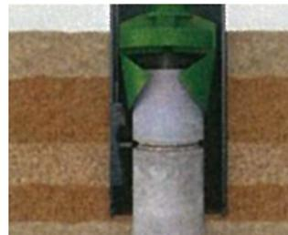
4.水平刃を元の位置に戻した後に、上部の油圧ユニットを取り外し、セリ矢により杭を切断する。
